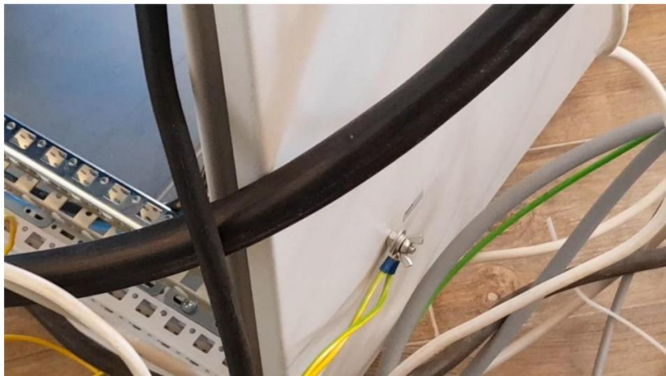
Рисунок 15 – Винт заземления стойки управления
